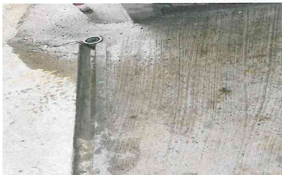
Foto 9: Colocación de tubería para agua y drenaje para pila.
