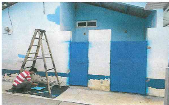
Foto 5: Sustitución de pintura de baños
