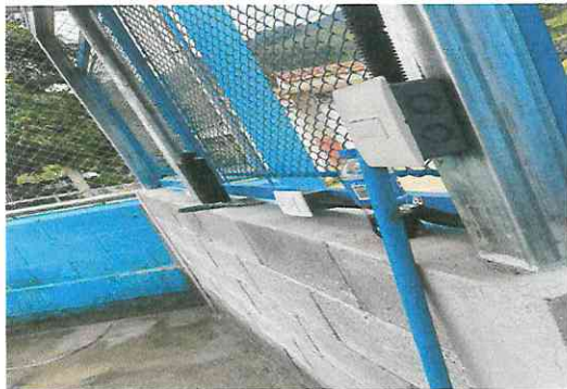
Foto 7: Sustrucción de suministro de electricidad en cocina.
