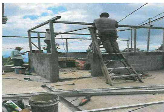
Sustitución de estufa rural, incluyendo, polleón y chimenea, sustitución de techo de madera por estructura metálica, cerramiento de alrededor de cocina a 1 metro de alto
