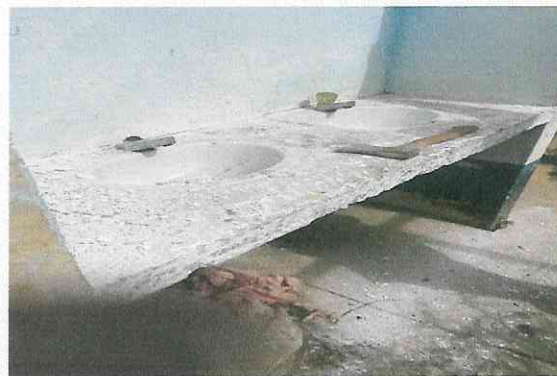
Foto 4: Cambio de 3 lavamanos con sus respectivos accesorios, colocación de azulejos en lavamanos
