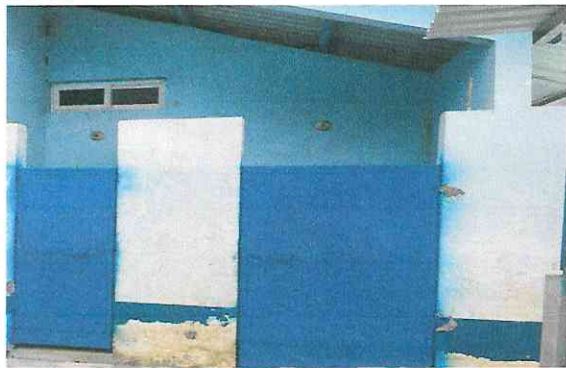
Foto 1: Reparación de 2 puertas de baños (Limpieza, Soporte y pintura)
