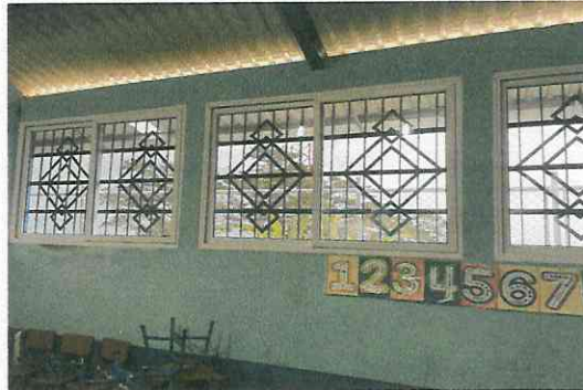
Foto 8: Sustrucción de ventanas a ventanas PVC
