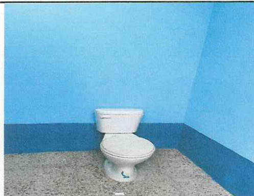
Foto 2: Cambio de 2 baños sanitarios con sus respectivos accesorios e instalación de azulejos.
